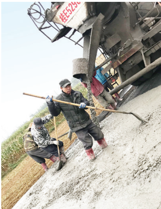
2018年12月,平阳镇赤东村委开工建设高架桥至电站道路,全程850米,路基宽5.5米,路面宽4.5米。图为施工现场
